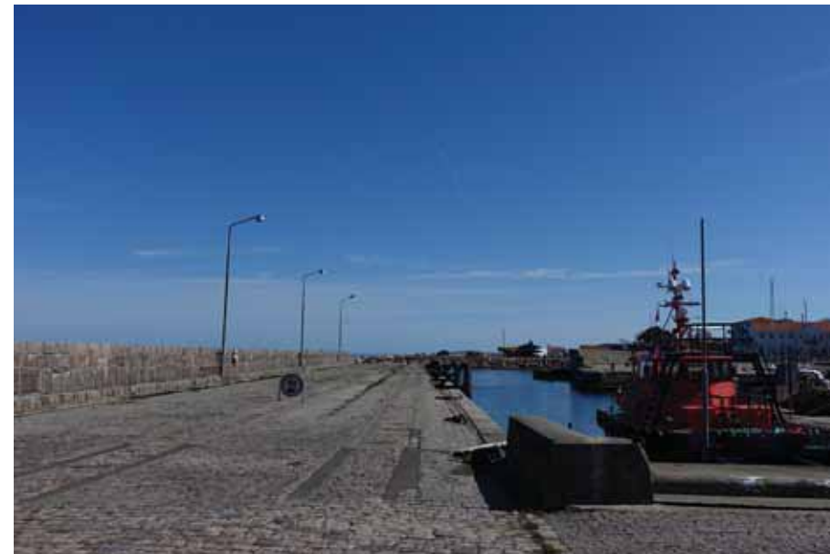
Ud over at være en fysisk barriere, skærmer kystsikringen også for den visuelle forbindelse til havet, som ellers bør være en kvalitet der er tilstede i enhver havneby.
