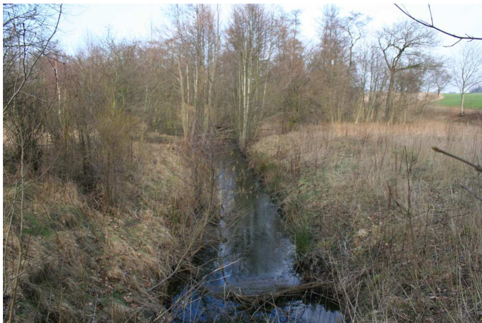
Figur 12 Afløbet fra Krummemose set fra rørindløbet mod nord
