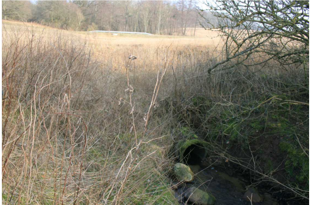
Figur 11 Den rørlagte øvre strækning set fra udløbet mod brønden ved vejen
