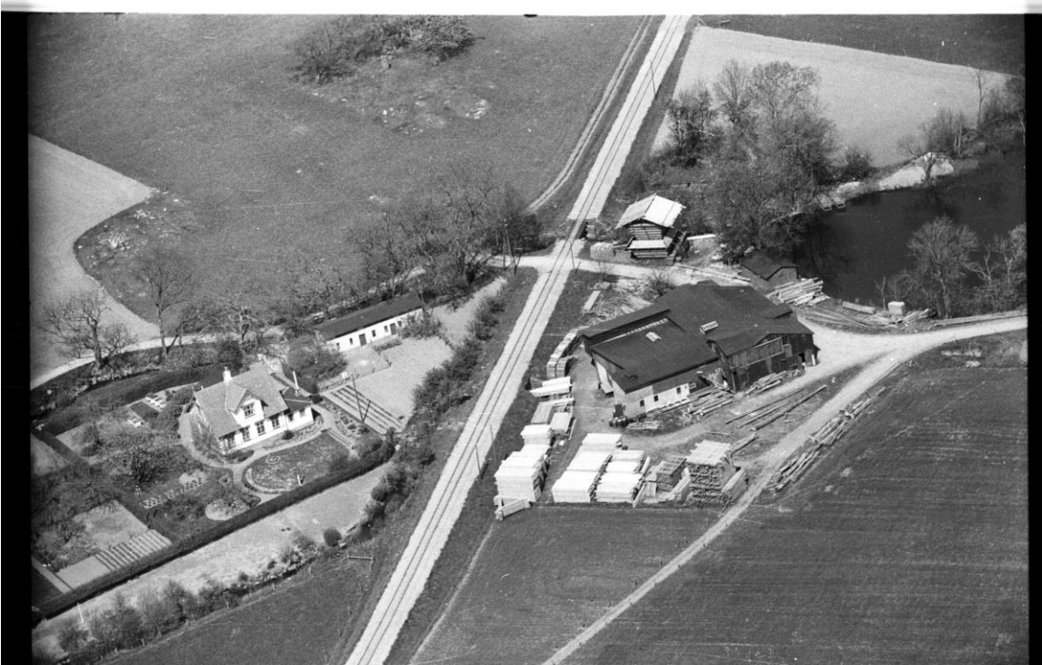
Bilag 3: Billede fra 1952 som viser savværket. Det ene udløb løb gennem savværket, hvor vandet blev brugt til at trække en turbine. Hovedløbet ses lige bag huset med det lyse tag.
