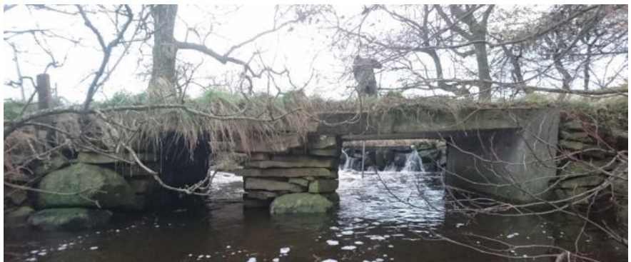
Figur 3.13: Broen set fra nedstrøms side. De flade natursten ses tydeligt. Dæmningen ses på den anden side af broen. Foto: NIRAS 2017-11-15
