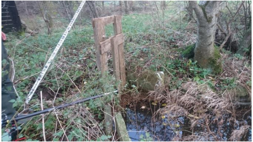
Figur 3.6: Slusen i træ i dæmningens østlige ende leder vandet fra møllesøen og gennem dæmningen til møllehjulet på nedstrøms side. Ramme omkring slusen er opbygget i beton og natursten. Hjørnet af møllebygningen kan ses i fotoets øverste venstre hjørne. Foto: NIRAS 2017-11-15
