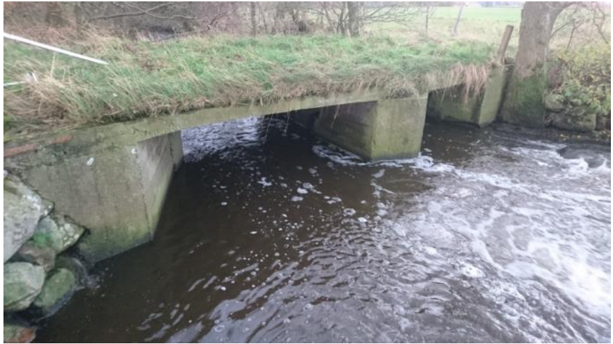
Figur 3.12: Umiddelbart nedstrøms dæmningen findes en bro. Broens fundament og piller er opbygget i store flade natursten. Dækket samt opstrøms side af fundamen og piller er støbt i beton. Foto: NIRAS 2017-11-15
