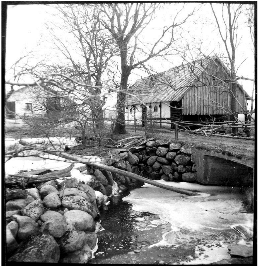
Figur 3.5: Der findes enkelte historiske fotos af møllen og arealerne omkring møllen, bl.a. dette. Som det ses er bygningen ikke uændret fra dette foto fra 1980 og på fotoet fra besigtigelsen vist i ovenstående foto. Dæmningen fremstår dog i væsentligt bedre stand i 1980 end den gjorde ved besigtigelsen. Der er ikke tydelig gennemstrømning af dæmningen på det viste foto. Foto modtaget fra Bornholms Regionskommune 16. nov. 2017.
