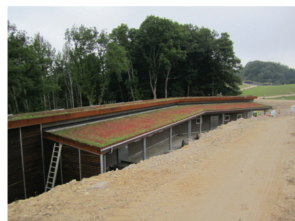
Figur 29: Sedumtag, Ree dyrepark. Foto Orbicon
