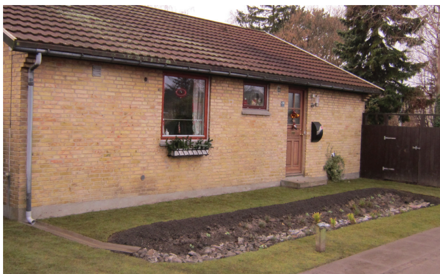
Figur 18: Nyetableret regnbed. Regnvandet ledes til regnbedet via en åben fliserende. Ved skybrud vil vandet løbe ud på vejen (bort fra huset). Brøndby Kommune har efter en vurdering af det konkrete projekt, lempet for de vejledende afstandskrav til bebyggelse og skel. Foto Spildevandscenter Avedøre.
