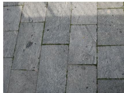
Figur 33: Permeabel flisebelægning i Ørestaden København. Regnvandet kan sive ned gennem belægningens fuger. Foto Orbicon.
